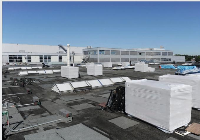
Sanierung einer Lagerhalle mit 7.800 m<sup>2</sup> Dachfläche: Austrocknung des durchfeuchteten Dachschichtenpakets
