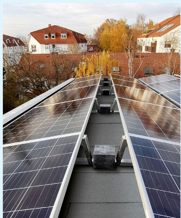
PV easywave erfordert nur eine einzige Bohrung – und zwar für die Kabeldurchführung
