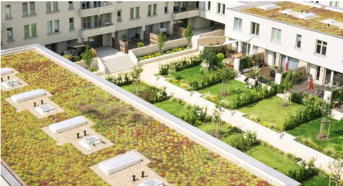
Das Icoflor-Begrünungssystem ist das Gründachsystem für jedes Dach. Leicht zu verlegen und langzeitbewährt. Das System hat eine geringe Aufbauhöhe und damit ein geringes Gewicht – selbst im wassergesättigten Zustand. Der gesamte Aufbau ist pflegearm und in wenigen Schritten aufgebracht.
