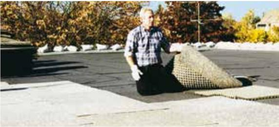
Die Icoflor-Platten werden dicht gestoßen, im Reihenverband mit der profilierten Seite nach unten, auf der durchwurzelungsfesten Abdichtung ausgelegt.
