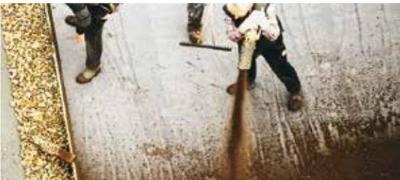
Das Erds substrat in einer Schichtdicke von ca. 4 cm (bei Silo-lieferung ca. 3,5 cm) gleichmäßig verteilen und anschließend auf ca. 3 cm verdichten. Hierzu eignet sich besonders gut eine Gartenwalze (Gewicht ca. 15 – 20 kg). Dieser Arbeitsschritt kann gleichzeitig mit dem Anwalzen der Sprossensaat erfolgen.
