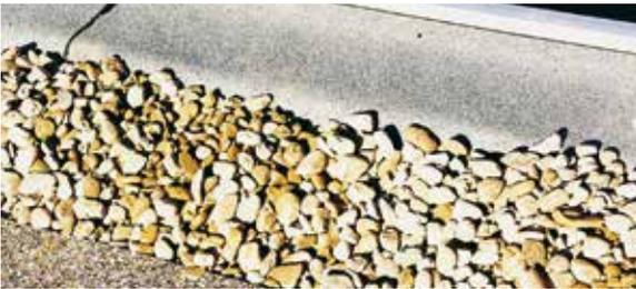
Anschließend die An- und Abschlussbereiche aus brandschutztechnischen Gründen in einer Breite von 50 cm mit einer Kiesschüttung, 16/32 mm, oder mit Gehwegplatten belegen.
