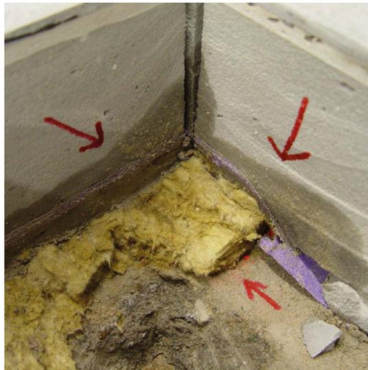
Fette, Öle, Reinigungsmittel und deren Abbauprodukte haben den Estrich getränkt und anschließend darunter liegende Schichten angegriffen.
