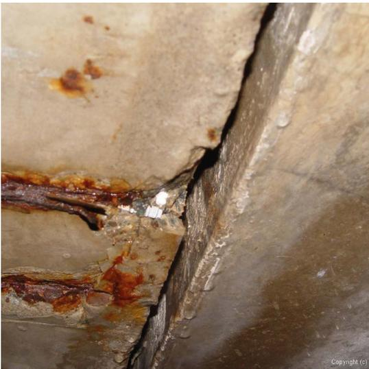
Der Bewehrungsstahl ist stark durch Milchsäure und andere Stoffe korrodiert und kann die Standsicherheit nicht mehr gewährleisten.
