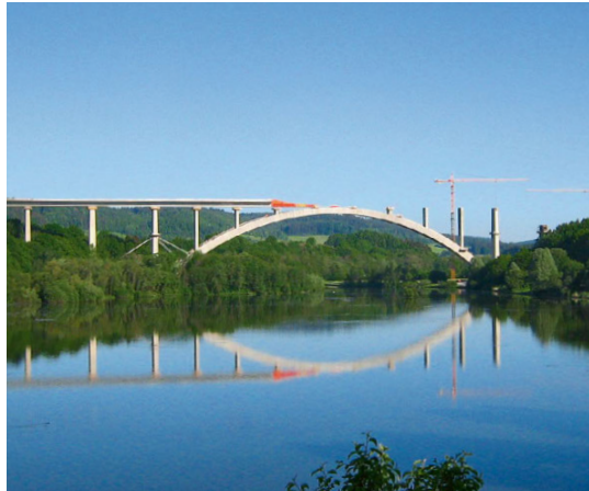
Talbrücke Froschgrundsee bei Weißenbrunn vorm Wald
