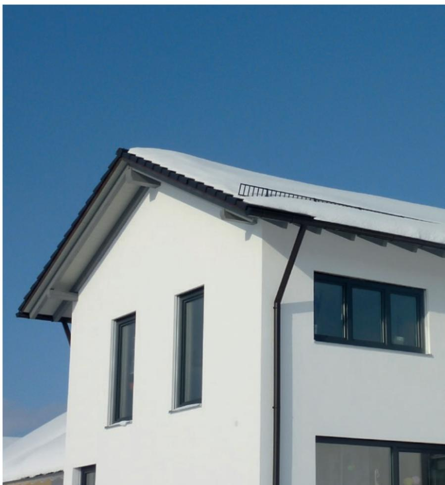
Ein Braas Dach mit einem Schneefanggitter zur Schneesicherung.
